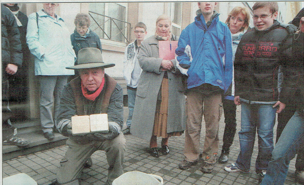
Gunter Demnig passt zwei Stolpersteine in den Pflasterverbund ein.
