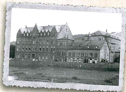
Außenansicht Herz-Jesu-Haus Kühr
