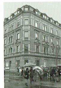
Ehemalige Gestapo-Zentrale, Kaisersstraße 31
