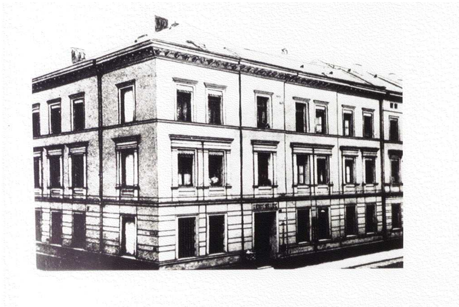
3) Staatspolizei(leit)stelle für den Regierungsbezirk Koblenz (Gestapo-Gebäude )"Im Vogel-sang 1- 3" (heute nicht mehr vorhanden, an seiner Stelle befindet sich eine Wohnbebauung)
