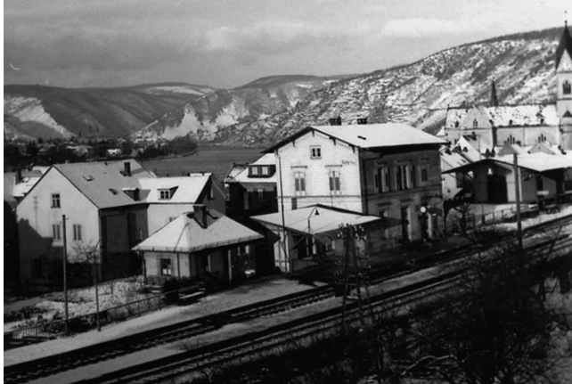
Abb. 8: Bahnhof von Kamp am Rhein, Winter 1964. Aussehen der Bahnanlage wie 1944/45. Das Abstellgleis, auf dem der Bauzug stand, ist heute entfernt (Foto: Verein für Heimatgeschichte Kamp-Bornhofen)
