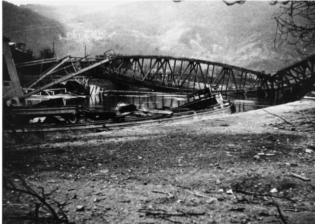
Abb. 9: Zerstörte Eisenbahnbrücke zwischen Ober- und Niederlahnstein über den Fluss Lahn, 1944/45 (Foto: Emil Simonis †, Sammlung Stadtarchiv Lahnstein)
