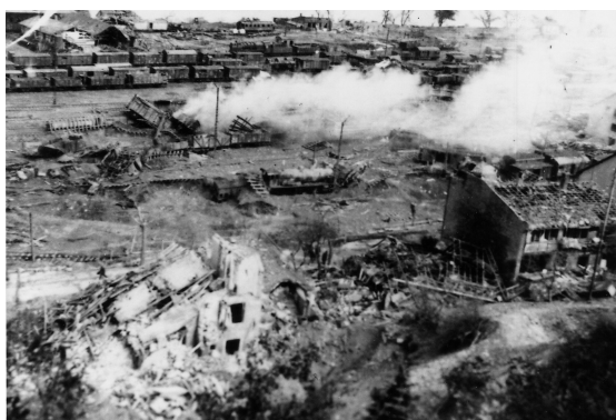
Abb. 3: Bahnhof Bingerbrück 1944/45: Zerstörte Bahnanlagen (Foto: Sammlung Heimatverein Bingerbrück)
