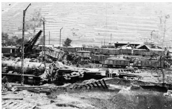
Abb. 2: Bahnhof Bingerbrück 1944/45: Zerstörte Gleisanlagen (Foto: Sammlung Heimatverein Bingerbrück)
