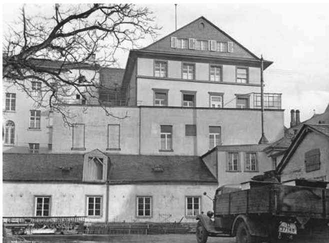
Abb. 4: Koblenzer Gestapogebäude Im Vogelsang; Foto aus einer Bauakte der Stadt Koblenz (s. eingezeichnete Fenster), Stadtarchiv Koblenz FA 2 Nr. 1040
